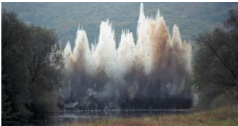
Het opblazen van een stuw aan de Sauer in Luxemburg met ondersteuning van Rijnland-Palts
