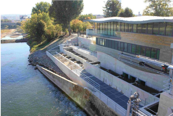
Figure 23 : passe à poissons et centre d'information « Mosellum » sur le barrage le plus aval de la Moselle à Coblenz (photo : Christian von Landwüst)
