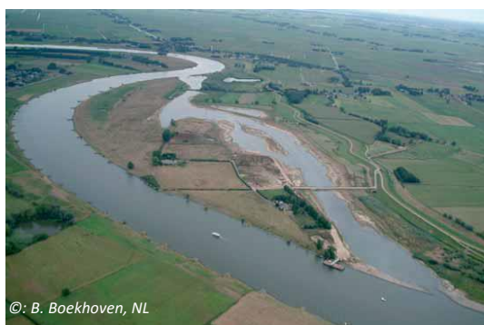
Foto: Realisierung eines leitbildkonformen Nebengerinnesystems an der IJssel (Vreugderijkerwaard)
