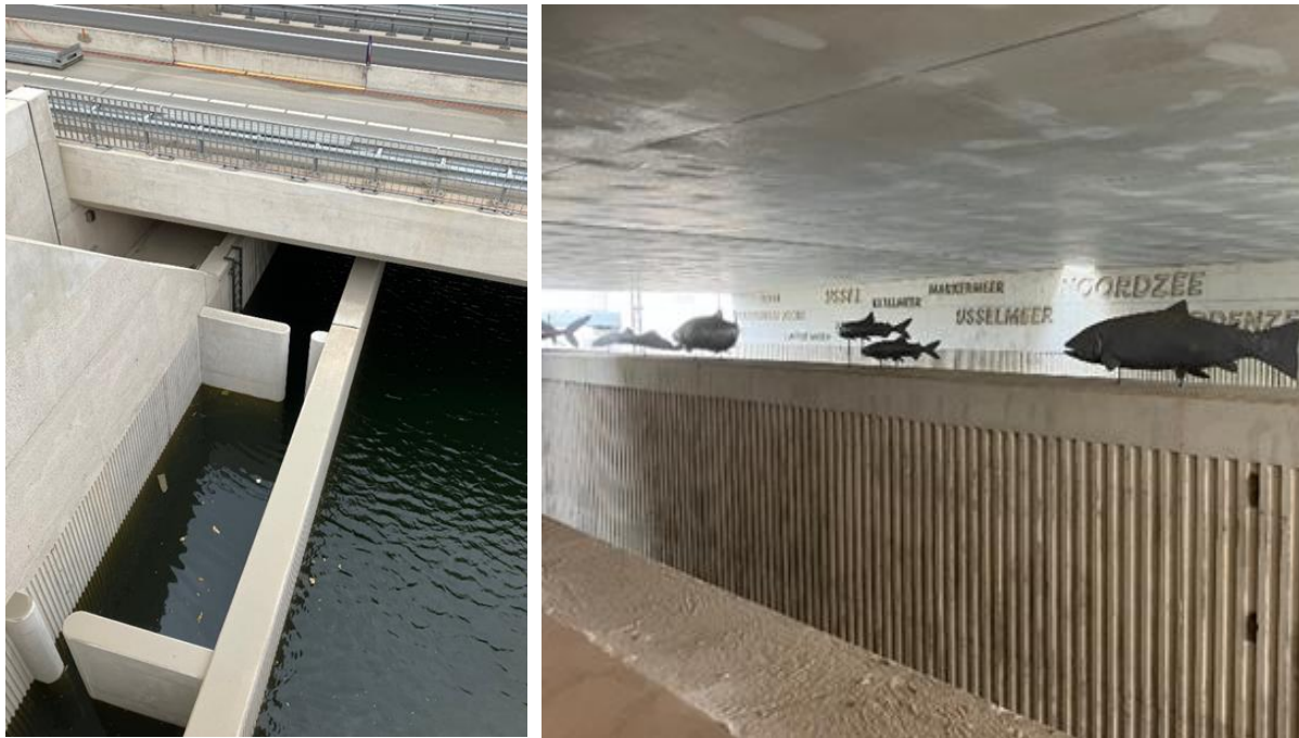
Figuur 5: Aanleg van het technische deel van de Vismigratierivier; coupure door de Afsluitdijk, juni 2023 (foto's: Jochem Hop)
