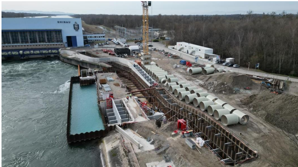
Figuur 2: Bouwwerkzaamheden aan de vispassage Rhinau in februari 2024 (foto: EDF).
