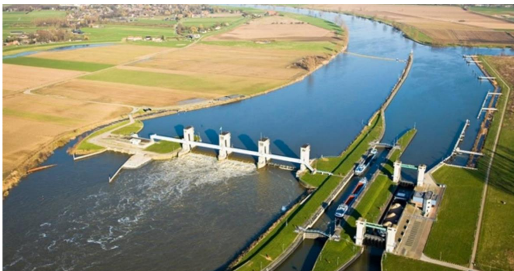
Figuur 7: Stuw te Lith (Maas) met aan de linkerkzijde de waterkrachtcentrale en vistrap en aan de rechterzijde de scheepvaartsluis (foto: Rijkswaterstaat)
