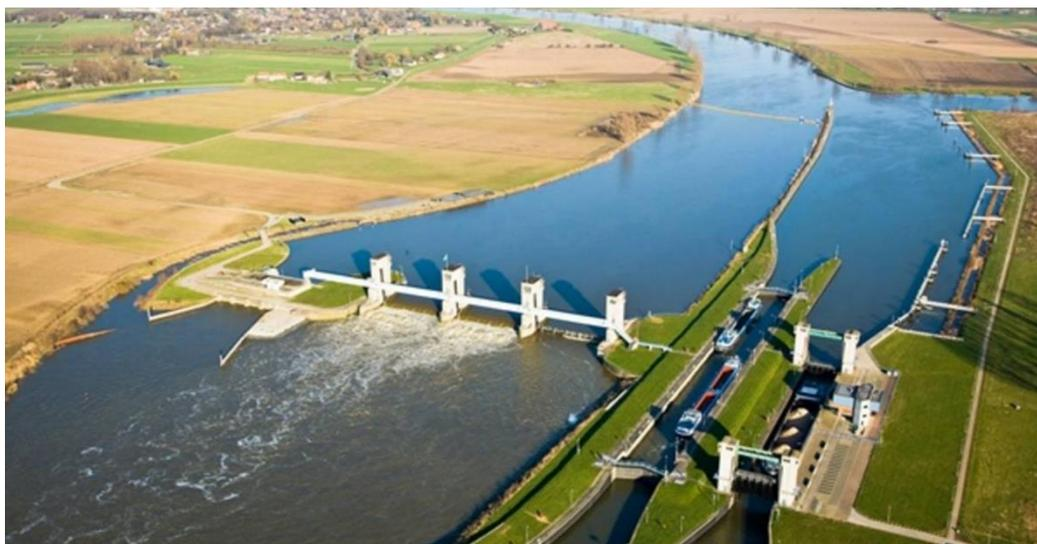
**Figure 7** : Retenue de Lith (Meuse). À gauche l'usine hydroélectrique et la passe à poissons, à droite l'écluse de navigation (photo : Rijkswaterstaat).
