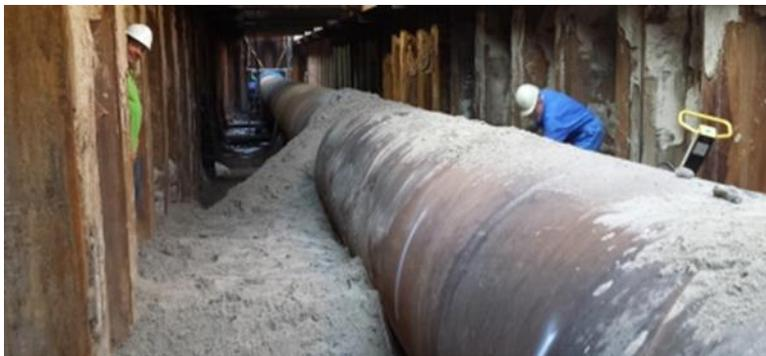
Figure 9 : photo donnant une idée de la taille de la conduite (diamètre de 1,5 mètre).
