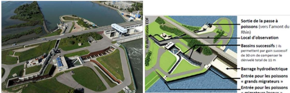
**Figure 20 : passe à poissons sur le barrage de Gamsheim**
