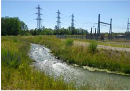
**Figure 24 : rivière de contournement pour la remontée des poissons à Strasbourg**
