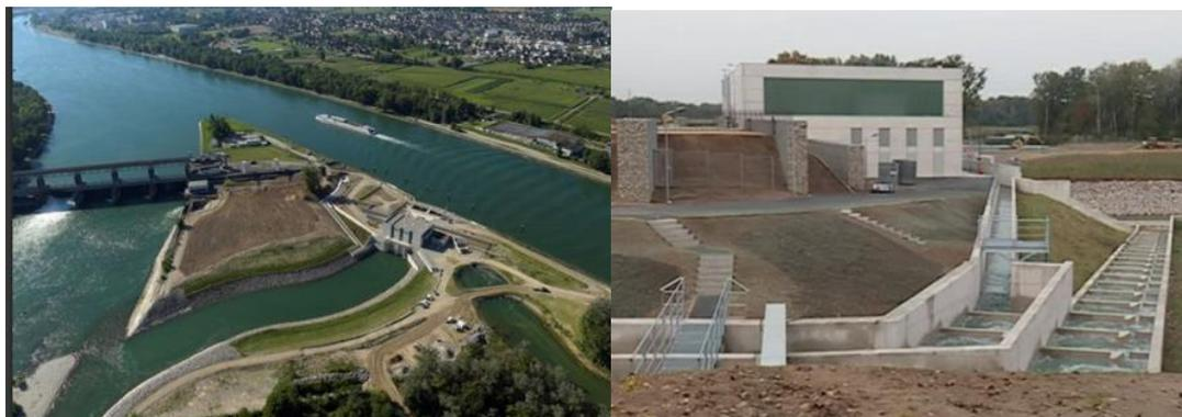
**Figure 30 : vue du site du barrage et de la passe à poisson de Kembs/Märkt.** À gauche : barrage de Kembs/Märkt ; Grand canal d'Alsace et Vieux Rhin. À droite : dispositifs de montaison sur le barrage de Kembs/Märkt. Photo : EDF
