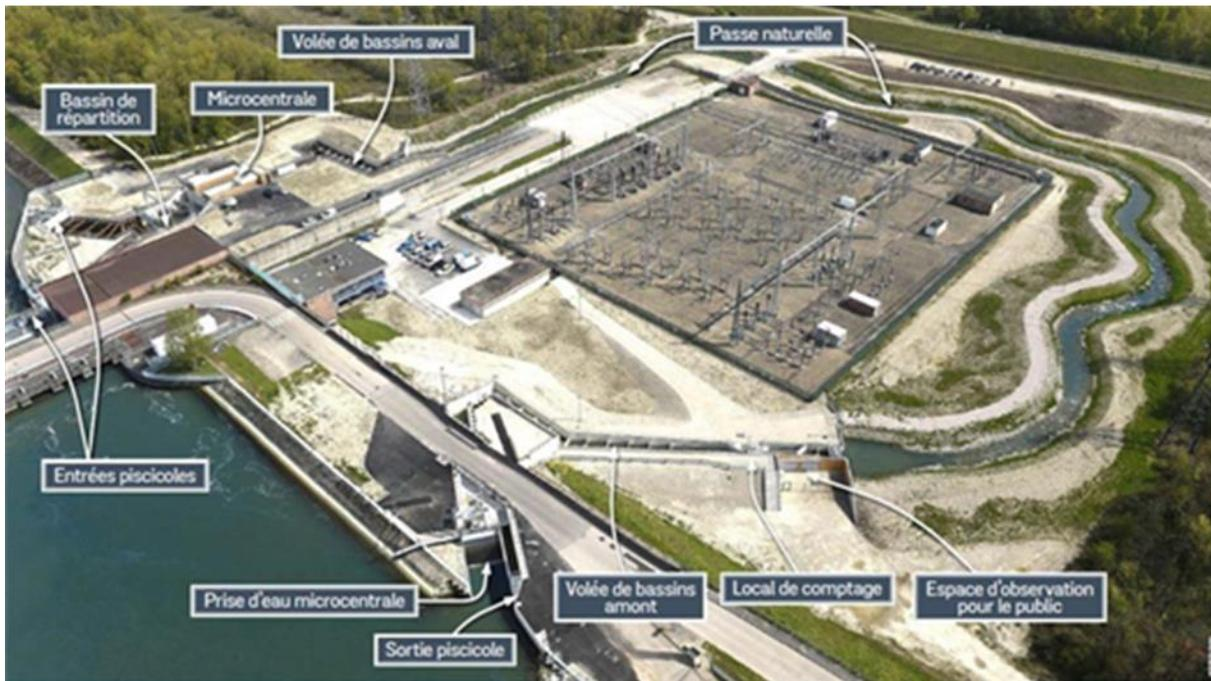
**Figure 21 : différents éléments de la passe à poissons de Strasbourg**
