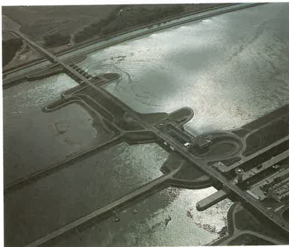
Le barrage d'Iffezheim
