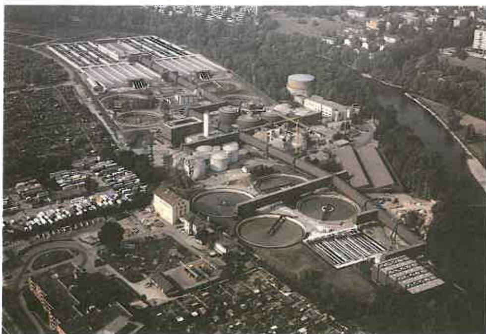
La station d'épuration "Werdhölzli" de la ville de Zurich
