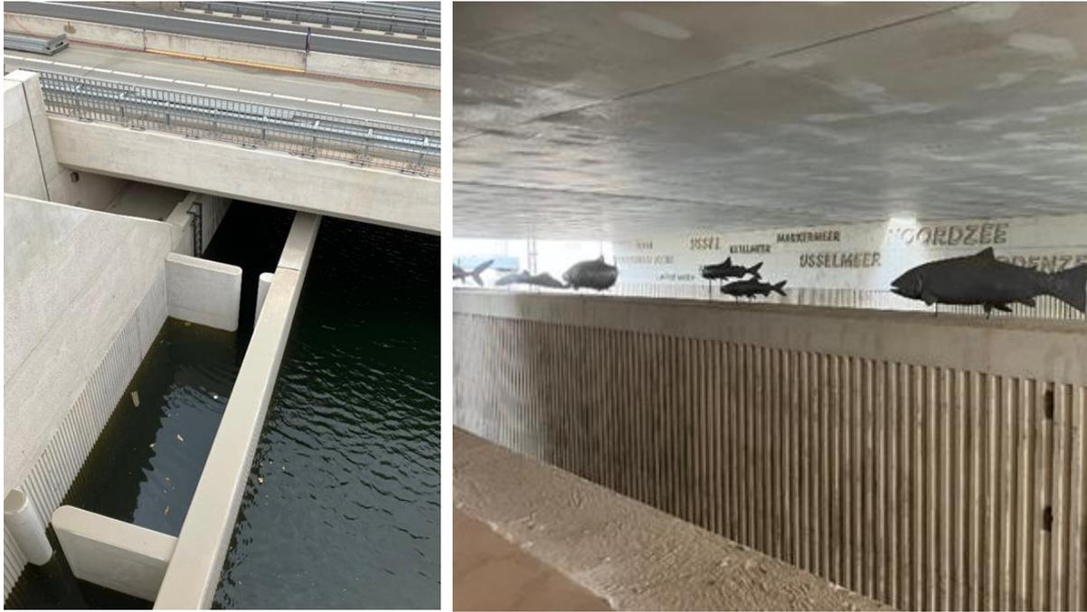
**Abbildung 5: Bau des technischen Teils des Fischwanderflusses; Durchlass im Abschlussdeich, Juni 2023** (Fotos: Jochem Hop)
