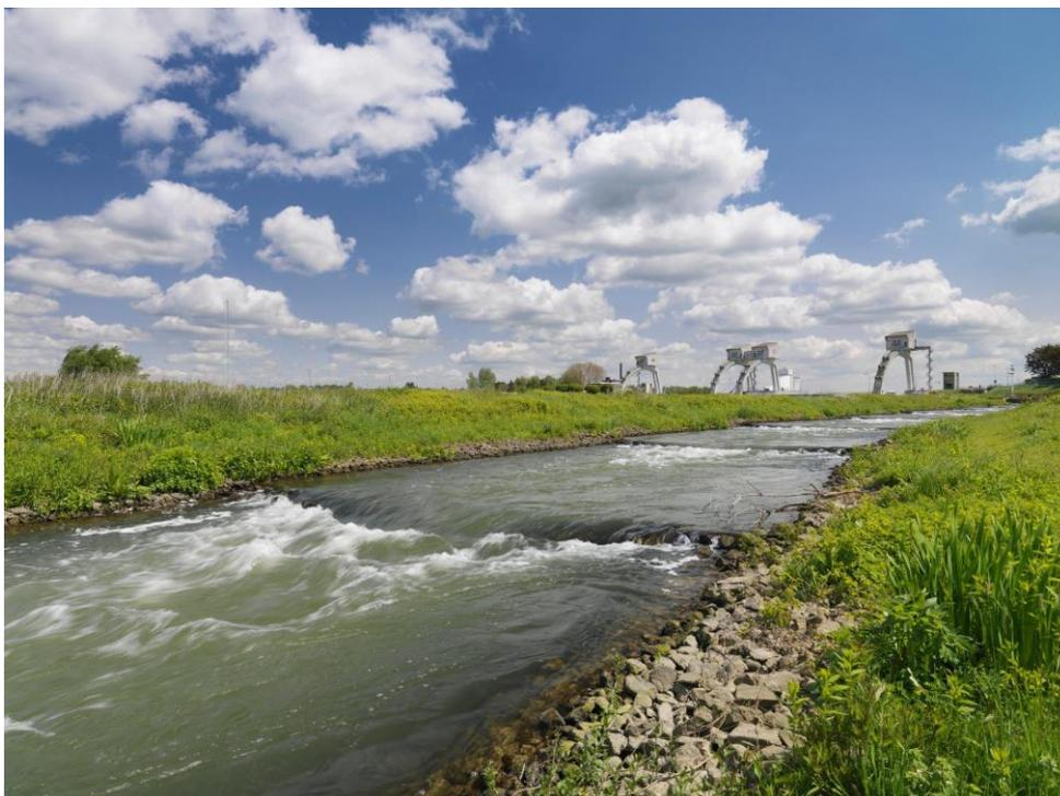
**Foto 4:** Hagestein-Wehr im Lek, Komplex aus Stauwehr und Schleuse, welches den Wasserhaushalt in den Niederlanden mitreguliert (Quelle: Tineke Dijkstra)
