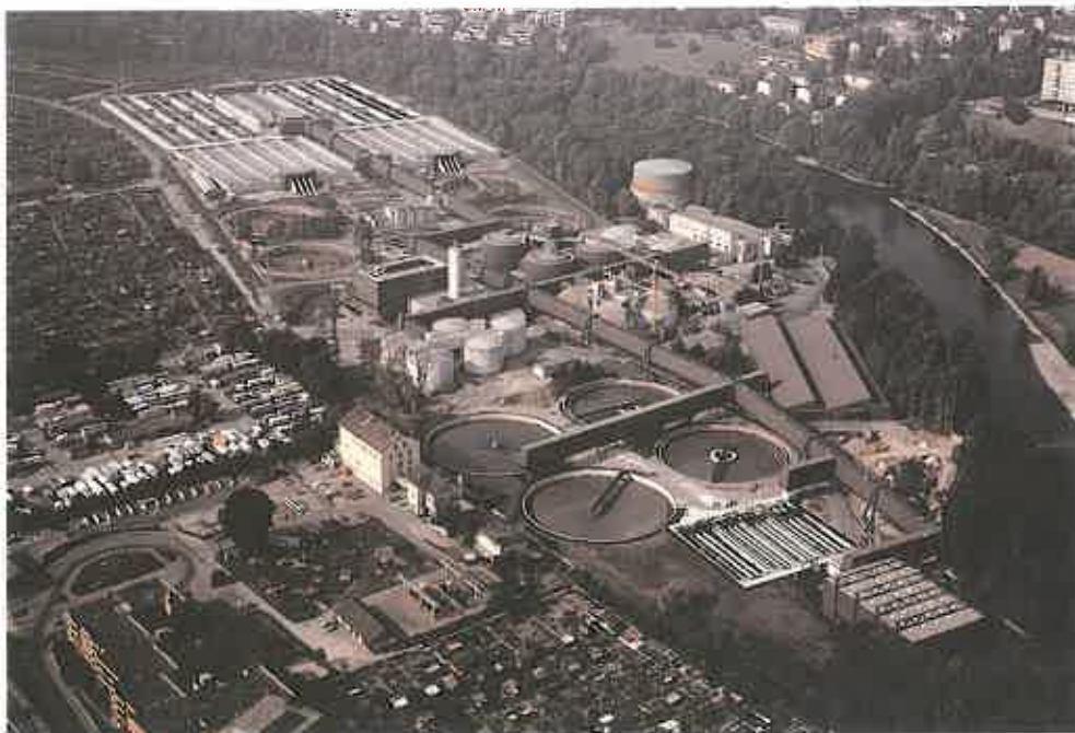
Kläranlage Werdhölzli der Stadt Zürich
