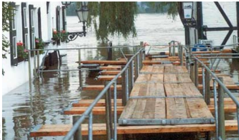
In geval van hoogwater worden loopplanken aangelegd
