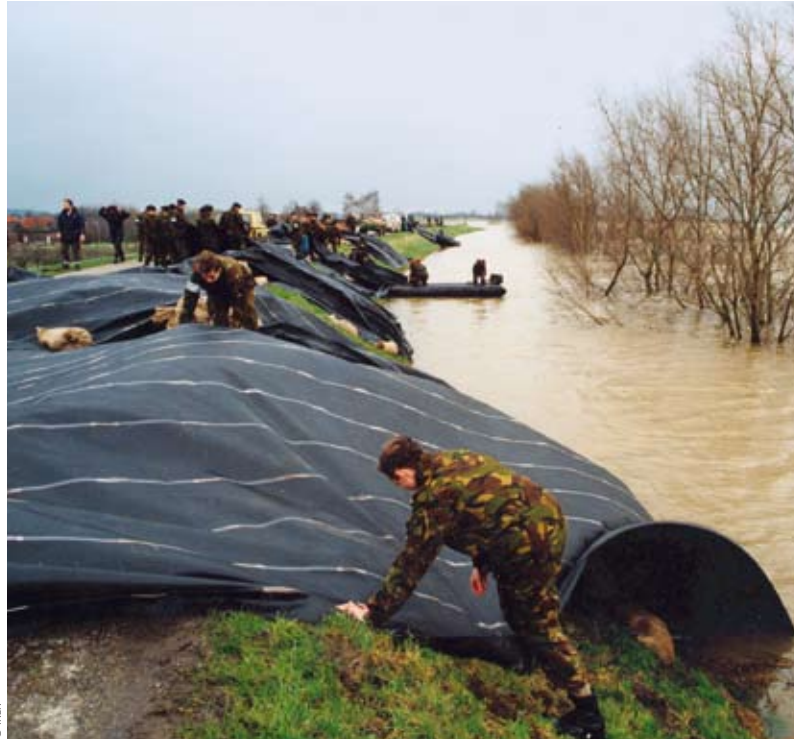
Afdichten van de dijk: in geval van nood met behulp van het leger
