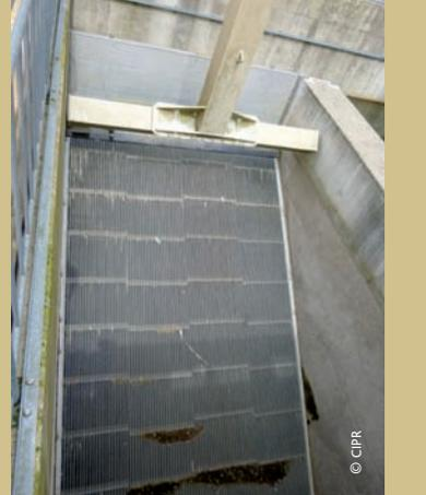
Les grilles détournent les poissons de l'entrée des turbines hydroélectriques.
