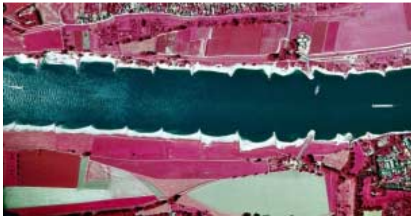
Buhnenausbau bei Düsseldorf – Kaiserswerth (Infrarotbild)
