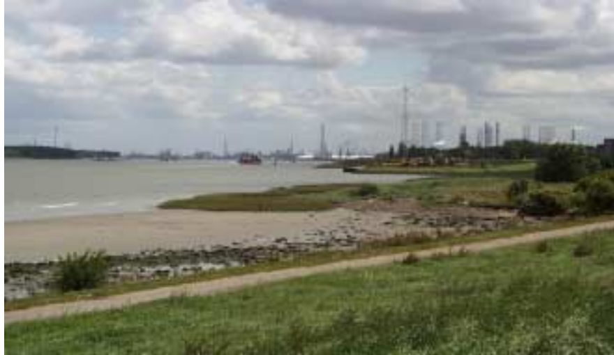
Auch im industriereichen Unterlaufgebiet (z.B. Rozenburg am Nieuwe Waterweg) gibt es selten natürliche Ufer und natürliches Gewässerumfeld wie Groden Rozenburg am Nieuwe Waterweg, km 1019 (Foto: C. Storm)
