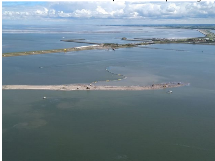
Figuur 24: Aanleg van de vismigratierivier, juli 2020 © Rijkswaterstaat
