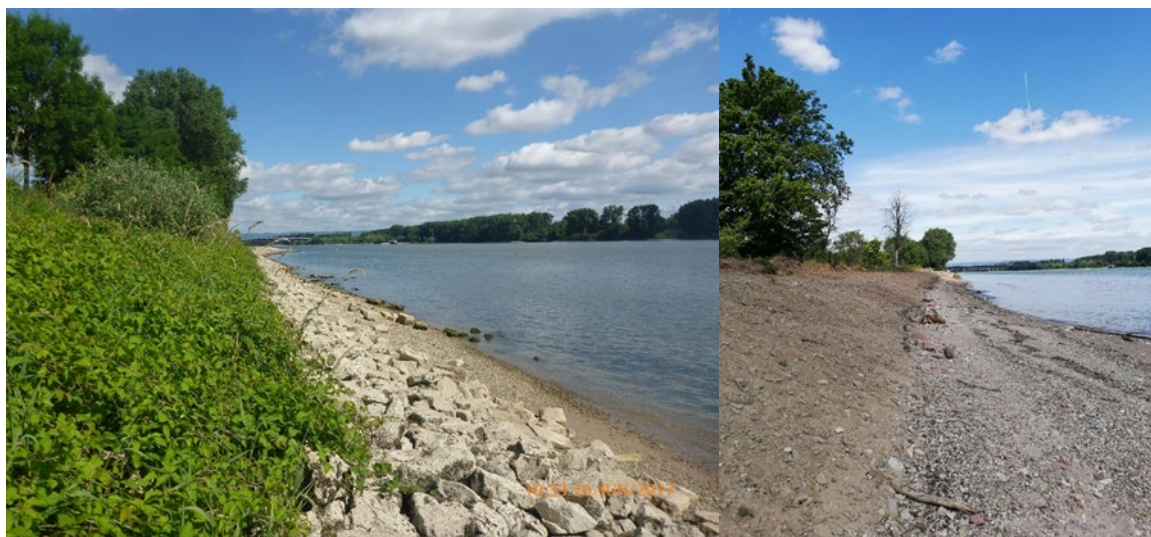
Figuur 29: Rijnoever Mainz-Laubenheim (Rijnland-Palts) voor (links) en na (rechts) de hydromorfologische maatregel - overgang van een verharde oever naar een vlakke oever (foto's: Dorothea Gintz, BfG; Corinna Krempel, BfG)
