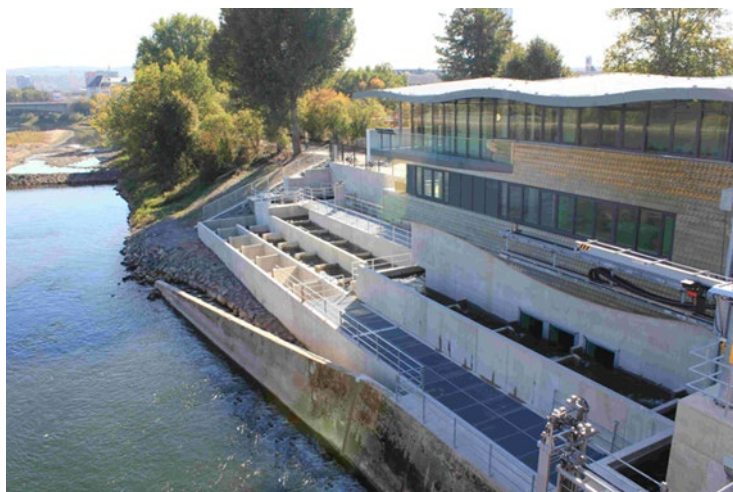
Figuur 25: Vispassage aan de onderste stuw in de Moezel te Koblenz en het bezoekerscentrum "Mosellum" (foto: Bernd Mockenhaupt)
