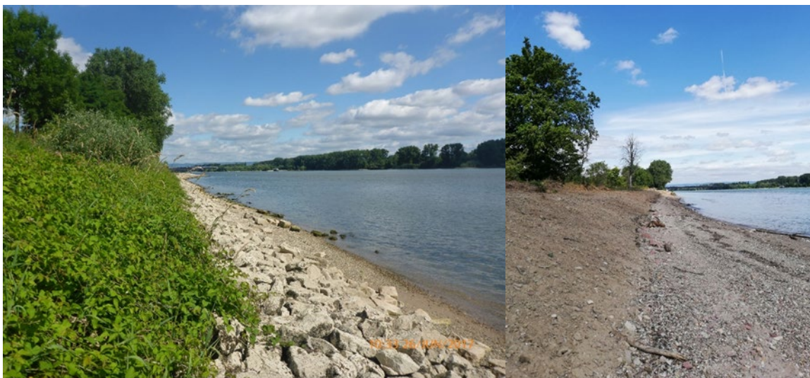
Figuur 29: Rijn-oever Laubenheim voor (links) en na (rechts) de hydromorfologische maatregel - overgang van een verharde oever naar een vlakke oever (foto's: Dorothea Gintz, BfG; Corinna Krempel, BfG)
