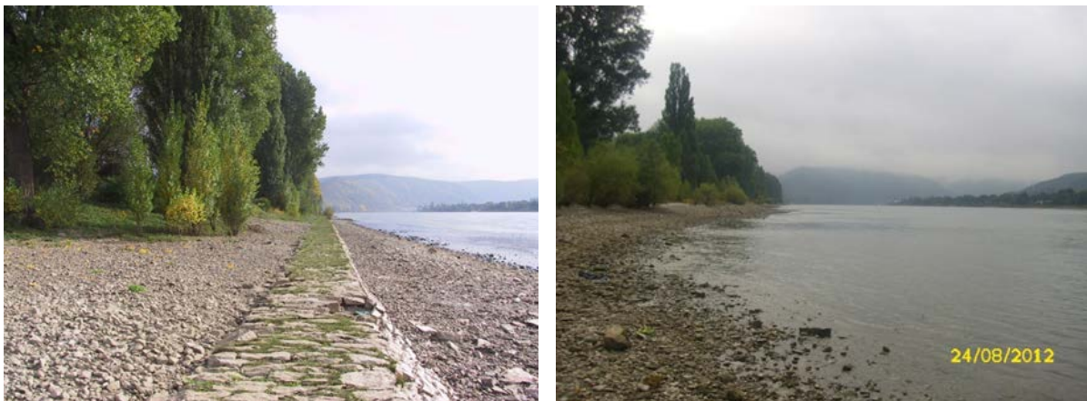
Figuur 40: Rijnoever voor (links) en na (rechts) de hydromorfologische maatregel - overgang van een verharde oever naar een vlakke oever (foto's: Angelika Halbig, BCE; Ernst-Dieter Kuczera, SGD Nord)
