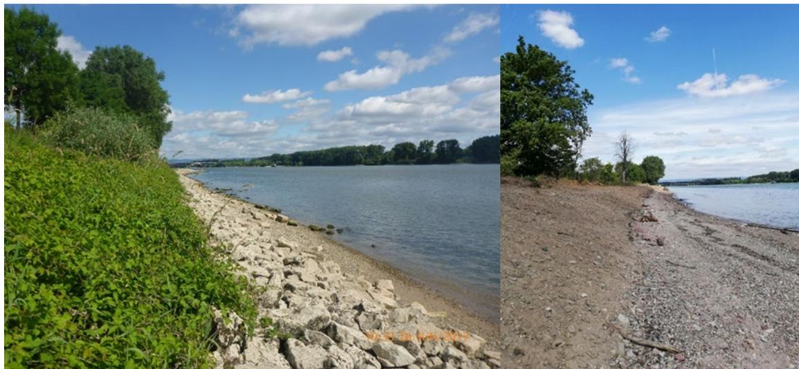
**Figure 29** : Berge du Rhin à Mainz-Laubenheim (Rhénanie-Palatinat) avant (à gauche) et après (à droite) l'amélioration morphologique - d'un aménagement rigide à une berge plate (photos : Dorothea Gintz, BfG ; Corinna Krempel, BfG)
