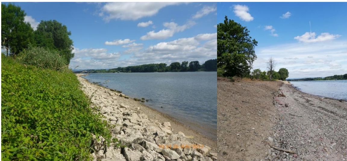
**Figure 29** : berge du Rhin à Laubenheim avant (à gauche) et après (à droite) l'amélioration morphologique - d'un aménagement rigide à une berge plate (photos : Dorothea Gintz, BfG ; Corinna Krempel, BfG)
