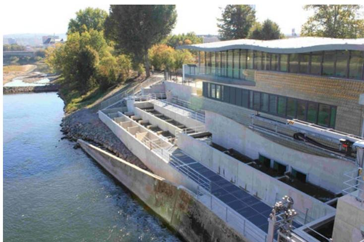
**Figure 25** : passe à poissons et centre d'information « Mosellum » sur le barrage le plus aval de la Moselle à Coblenz (photo : Bernd Mockenhaupt)
