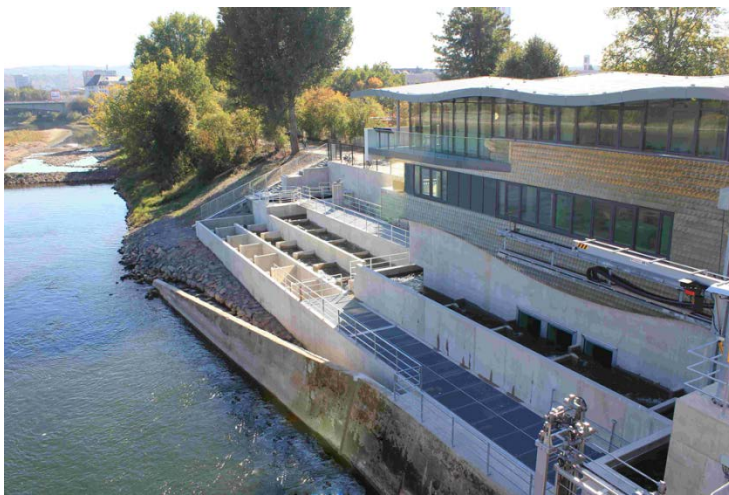
Figure 37 : passe à poissons et centre d'information « Mosellum » sur le barrage le plus aval de la Moselle à Coblençe (photo : Christian von Landwüst)
