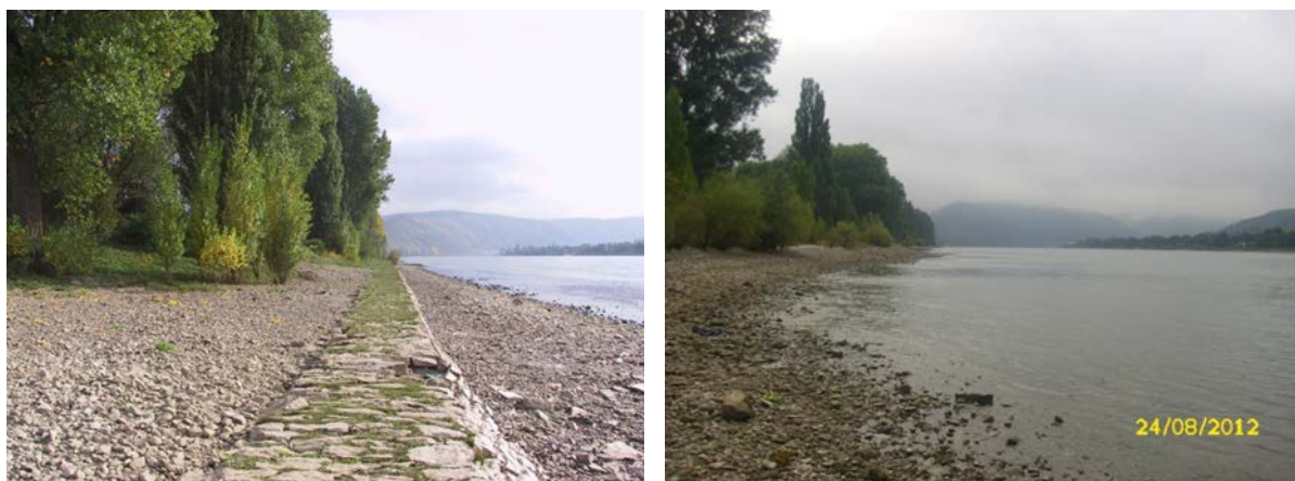
Figure 40 : berge du Rhin avant (à gauche) et après (à droite) l'amélioration morphologique - d'un aménagement rigide à une berge plate (photos : Angelika Halbig, BCE ; Ernst-Dieter Kuczera, SGD Nord).
