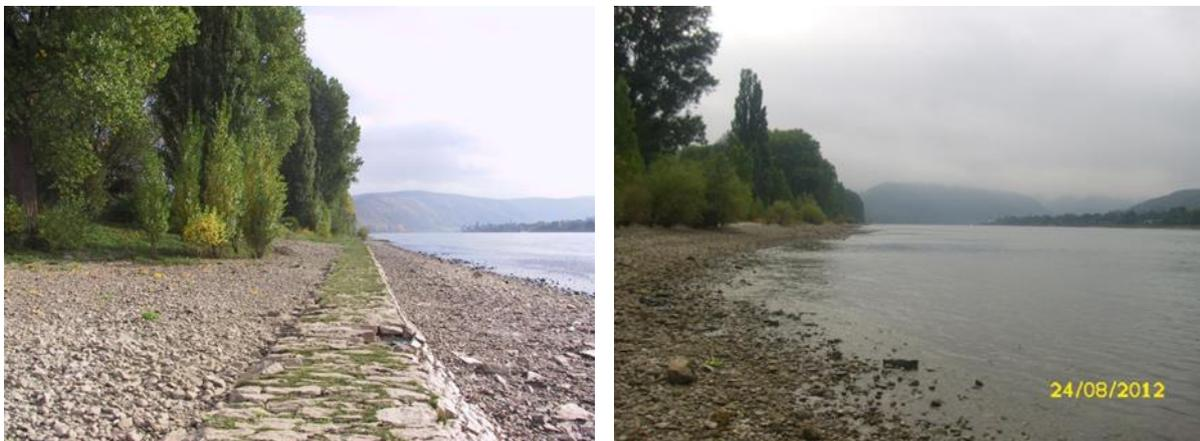
**Abbildung 40:** Rheinufer vor (links) und nach (rechts) der Strukturverbesserung – von harter Verbauung zum Flachufer (Fotos: Angelika Halbig, BCE; Ernst-Dieter Kuczera, SGD Nord).
