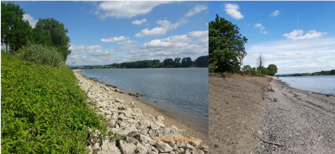
**Abbildung 29:** Rheinufer Laubenheim vor (links) und nach (rechts) der Strukturverbesserung – von harter Verbauung zum Flachufer (Fotos: Dorothea Gintz, BfG; Corinna Krempel, BfG).
